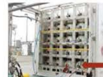
รูปที่ 1 การบรรจุไฮโดรเจนลง ท่อขนส่งไฮโดรเจน (tube trailer)
